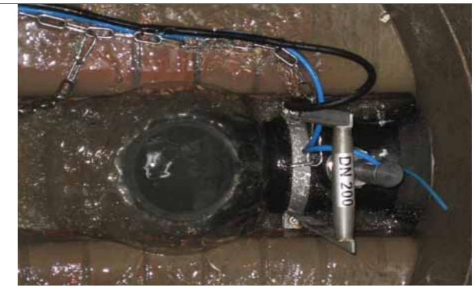
Mérőrendszer ideiglenes beépítése egy csatornába
