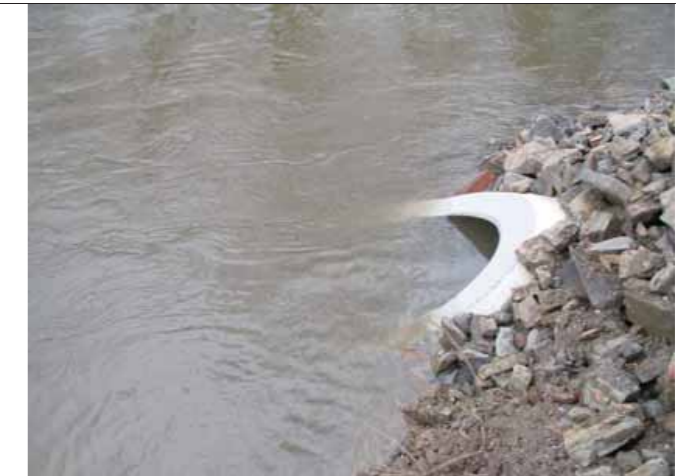
A túlfolyó csatorna érkezése a befogadóba (magas vízszint esetén)
