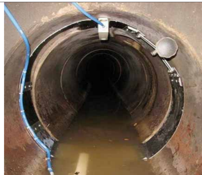
Áramlásmérési hely: áramlási sebesség és szint érzékelők beépítve
