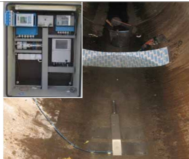
Online spektrométer szonda Balra fent: mérőszekrény
