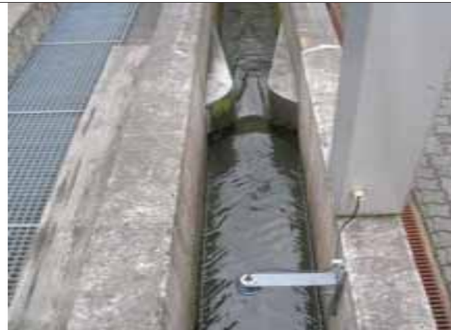
Venturi csatornás áramlásmérés
