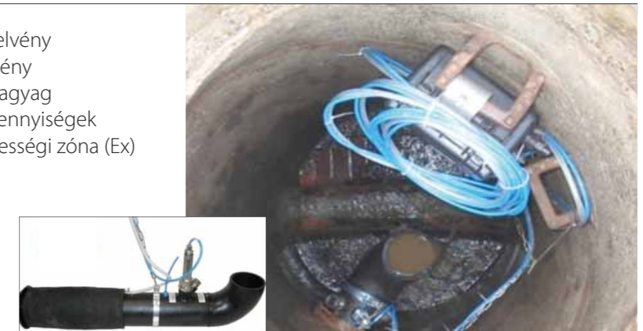
Mérési pont a csatornában
