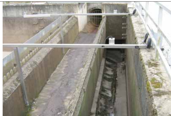
Átbukós vályú kialakítású elvezető medence
