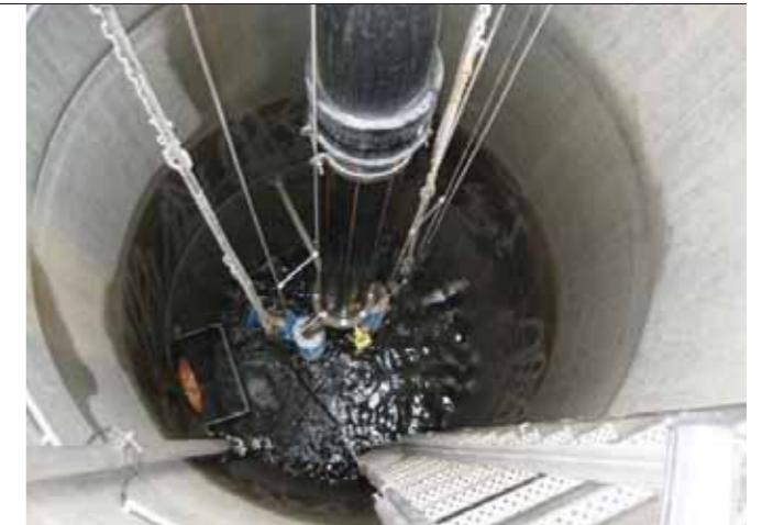
Szivattyúakna kettő szivattyúval
