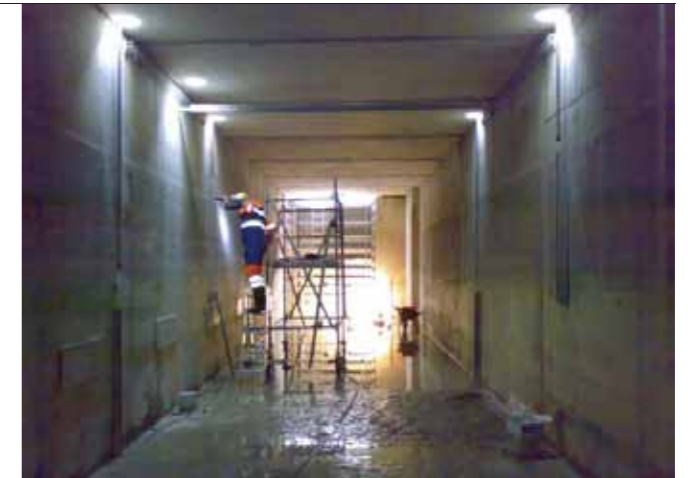
Az érzékelők beépítése a csatornába
