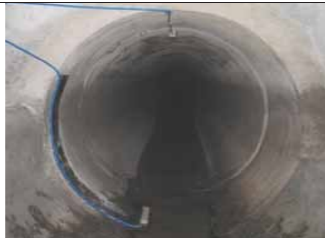
Mérési pont a csatornában
